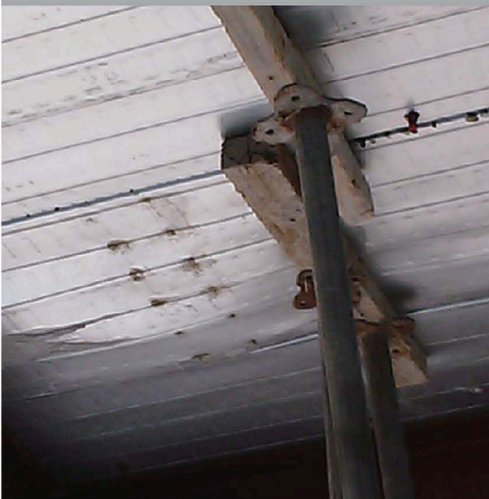
데크 개구부로 부터 콘크리트 균열 발생 [누수원인]
