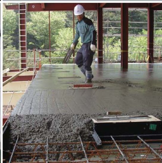
产品高度高，混凝土铺设量多(费用增加)
