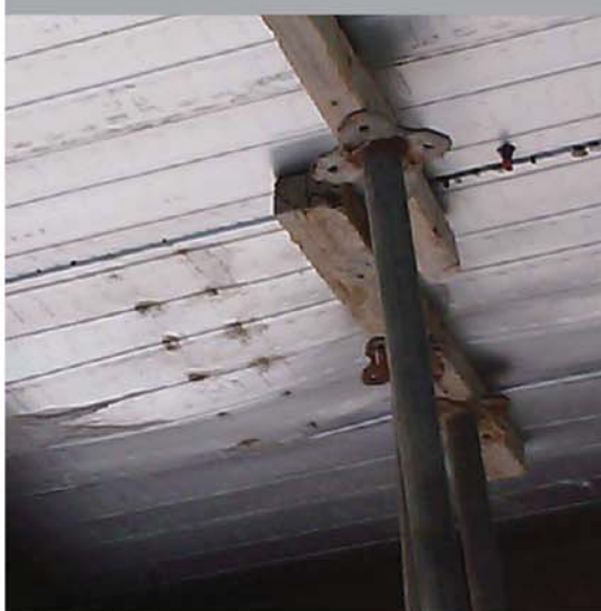
从台板开口部位发生混凝土龟裂(漏水原因)
