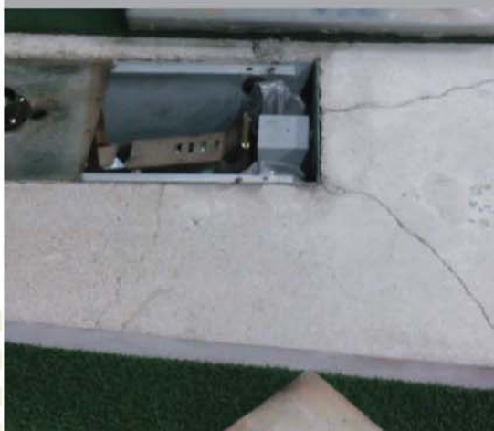
从台板开口部位发生混凝土龟裂(漏水原因)
